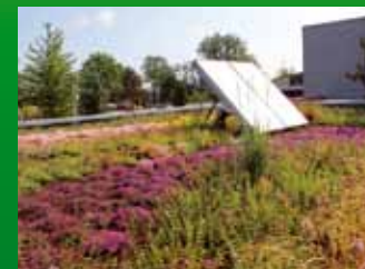
Thierry Muller, ingénierie et travaux du paysage - Toiture végétalisée sur local professionnel, Geispolsheim (67) Montant 10 920 €
