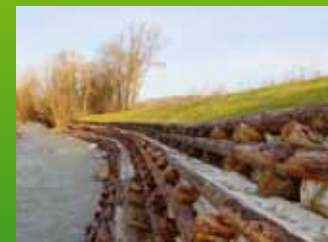
Millet Paysage Environnement Caisson végétalisés berges des USSES - Haute-Savoie (74) Montant 239 k€
