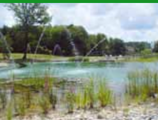
Tarvel, Création d'une baignade paysagère collective La Chapelle Saint-Sauveur (71) Montant 450 k€
